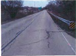
01 - W approach Frontage Rd.jpg
