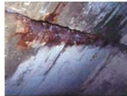
0220207-20111220-0016- Culvert~Stage joint minor...
