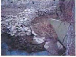
0220207-20111220-0004- Wingwalls~Channel on N...
